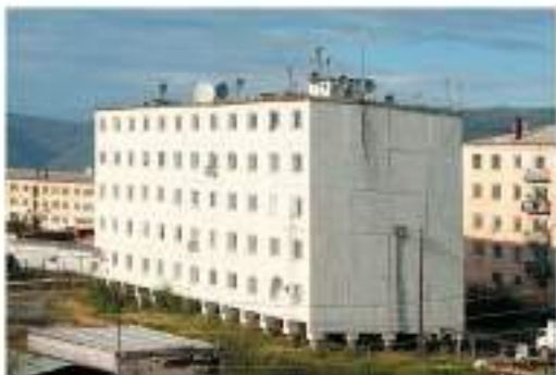
Рис. 77. Дома на сваях в Якутии
