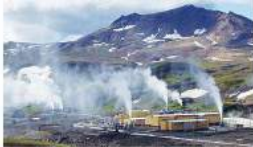
Рис. 164. Паужетская геотермальная электростанция (Камчатка)
